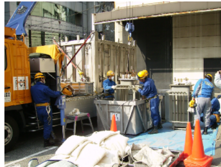
PCB廃棄物運搬の様子
