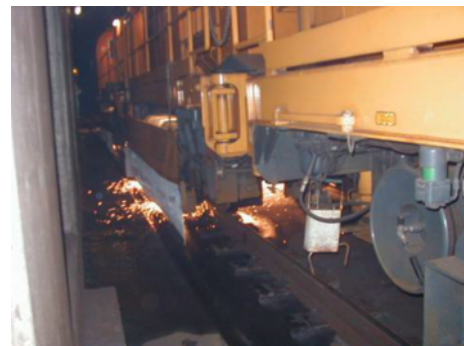
レール削正作業
