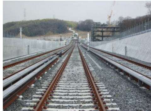
ロングレール敷設状況
