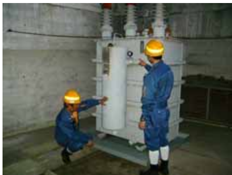
保管場所の点検風景
