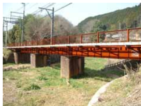
制振塗料を塗布した橋梁
