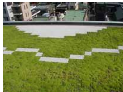
ビル屋上緑化事業
