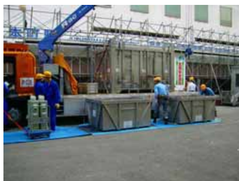
PCB廃棄物運搬の様子
