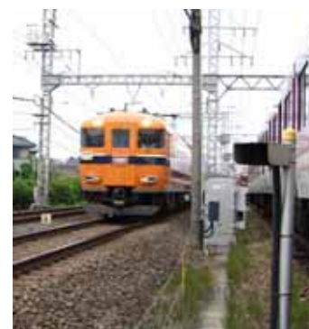
フラット検出装置
