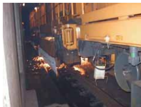
レール削正作業
