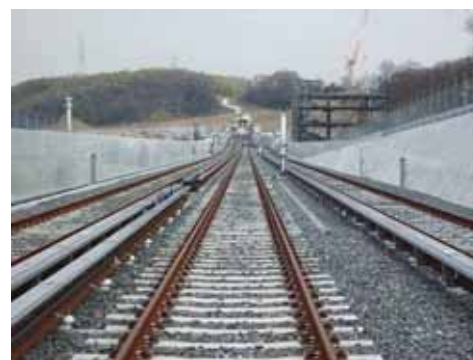
ロングレール敷設状況
