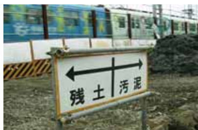
建設廃土置場
