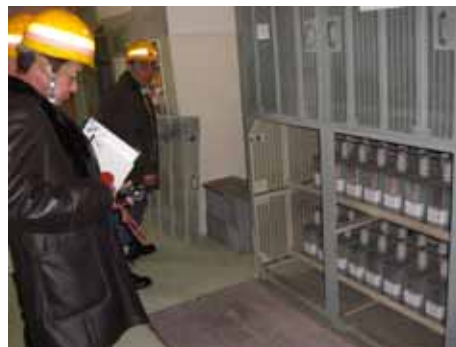
PCB廃棄物点検の様子
