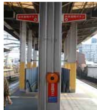
非常通報ボタン
