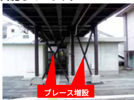
駅舎等の耐震補強工事（完了後）
