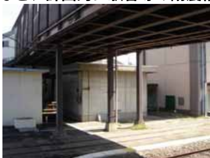
駅舎等の耐震補強工事（施行前）
