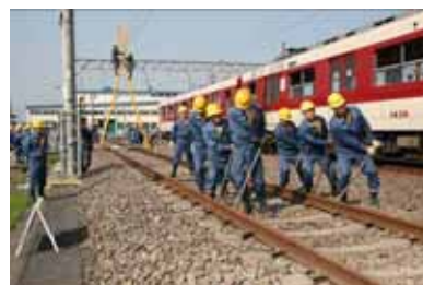
復旧作業を行う施設係員
