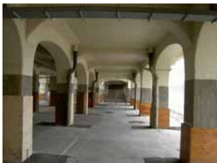
高架橋の耐震補強工事（施行前）
