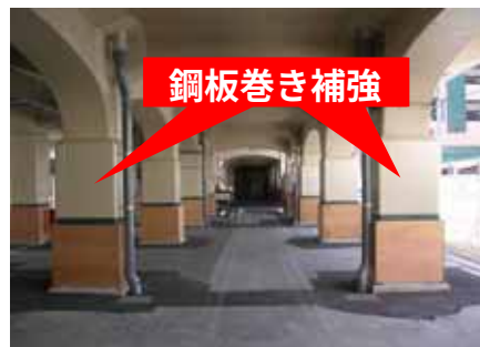
高架橋の耐震補強工事（完了後）
