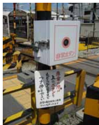
押ボタン式踏切支障報知装置 非常押ボタン
