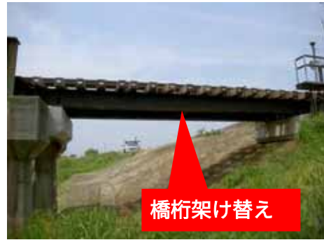
橋梁対策工事（完了後）
