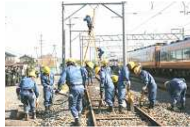
復旧作業を行う施設係員
