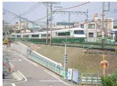
名古屋線伏屋駅付近
