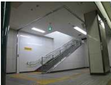
避難階段通常の状態
