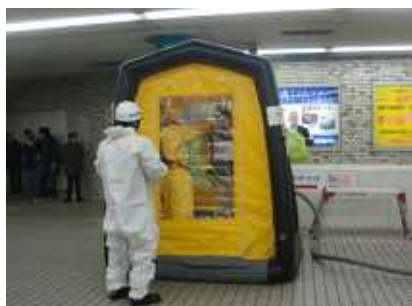
テント内での除染作業
