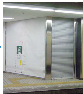
シャッターと耐火スクリーンを 下ろした状態
