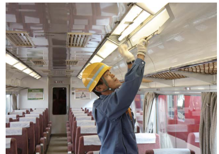
車内蛍光灯の検査
