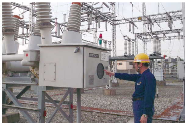
変電所設備保守点検
