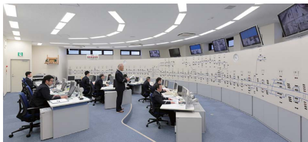
名古屋運転指令室
