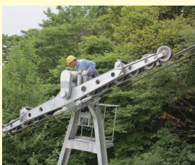
支索(ロープ)の検査
