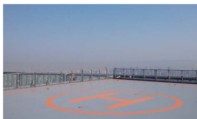
ヘリポート(屋上)
