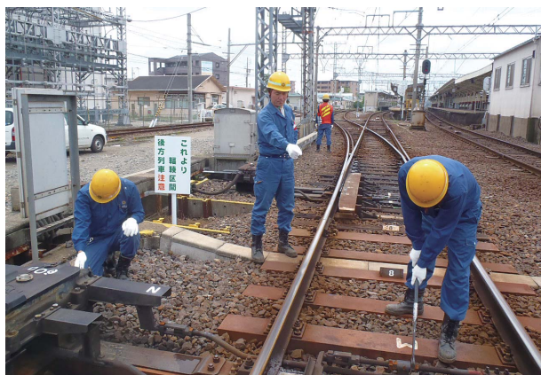
点検作業の様子
