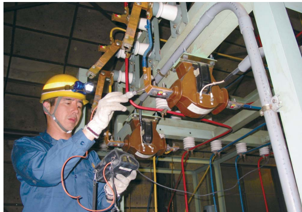
変電所設備保守点検
