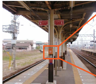
非常通報装置
