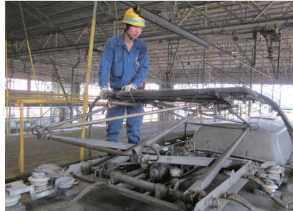
パンタグラフの検査
