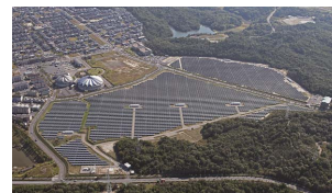
近鉄伊賀ゆめが丘ソーラー発電所(ソーラー発電事業)
