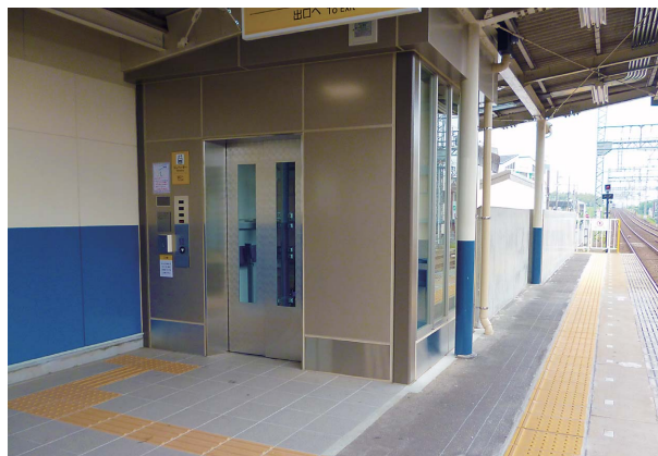
富野荘駅 エレベーター
