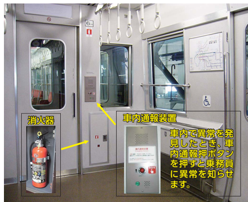
消火器と車内通報装置
