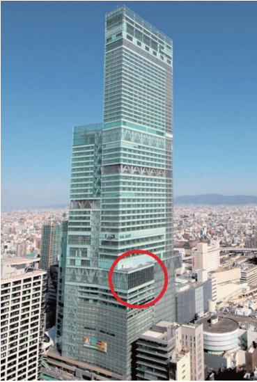
あべのハルカスタワー館南面の太陽光パネル
