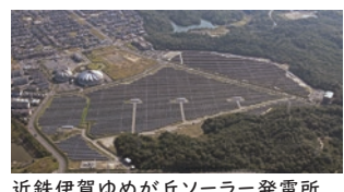
近鉄伊賀ゆめが丘ソーラー発電所 （ソーラー発電事業）
