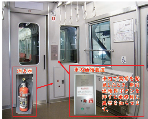
消火器と車内通報装置
