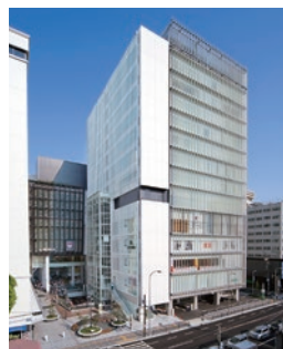
上本町YUFURA（商業ビル）
