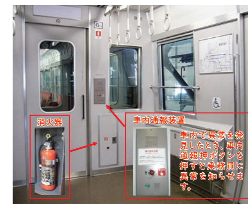
消火器と車内通報装置
