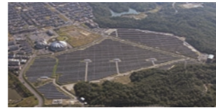
近鉄伊賀ゆめが丘ソーラー発電所 (ソーラー発電事業)
