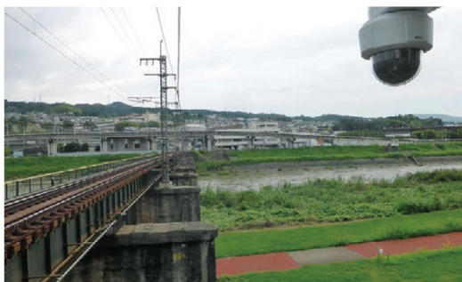
河川監視カメラ（大和川橋りょう 王寺～信貴山下間）
