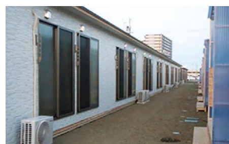
応急仮設住宅
