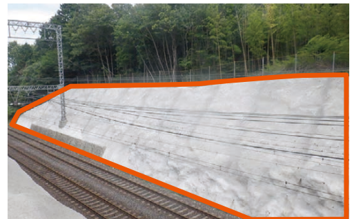
法面補強（三本松～赤目口間）
