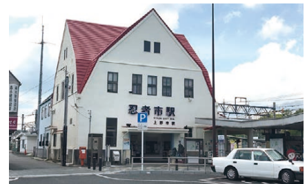
耐震補強と塗替が完成した忍者市(上野市)駅駅舎
