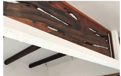
欄間・古木のリユース
