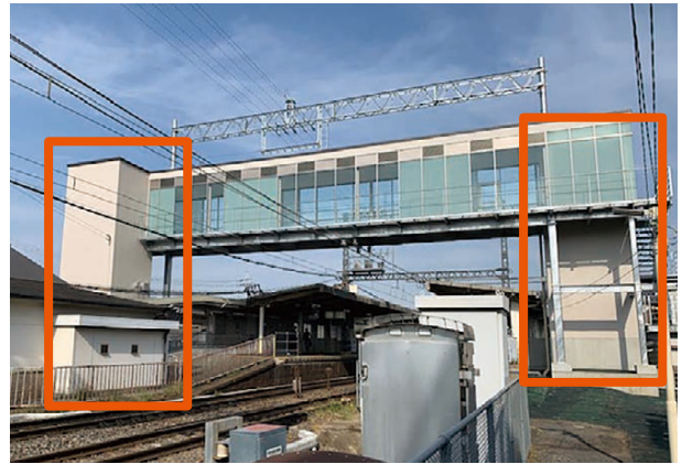
布忍駅 エレベーター
