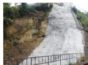
法面補強工事(長野線)
