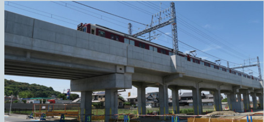
長野線 喜志駅～富田林間駅(踏切廃止箇所)
