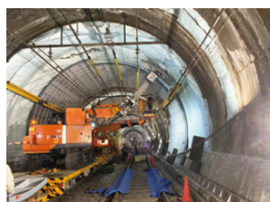
難波線シールドトンネル耐震補強工事
