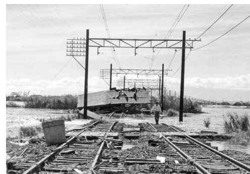
伊勢湾台風で被害を受けた名古屋線 (1959年)
