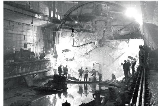
難波地下線建設工事の様子(1969年)
