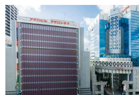
きんえいアポロビル・あべのルシアス
