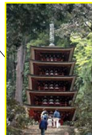
室生寺の五重塔 (内部初公開)
