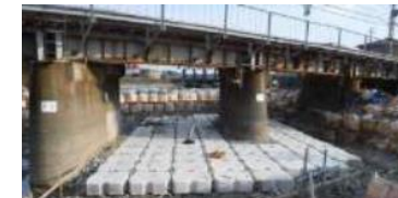
▲橋梁洗堀対策工事の実施
