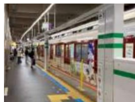
◀整備済の可動式ホーム柵 (大阪阿部野橋駅)
