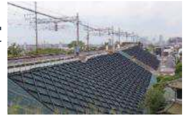
▲線路の法面強化
