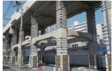
▲耐震補強工事
