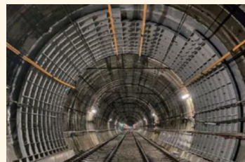
▲近鉄日本橋駅～大阪難波駅間でトンネル耐震補強工事を進める
