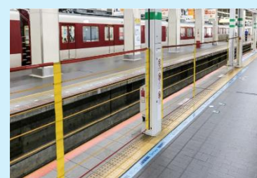
▲ドア位置が異なる等、多岐にわたる車種に対応できるロープ型の可動式ホーム柵の設置を進める
