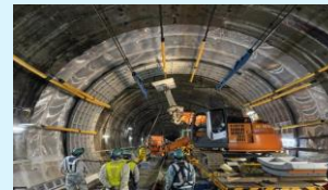
▲難波トンネル耐震補強工事
